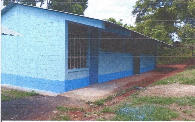
Foto 1: ESTADO ACTUAL DE LAS AULAS
