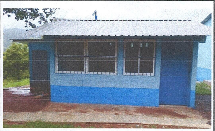
Foto 2: ESTADO ACTUAL DE LA COCINA
